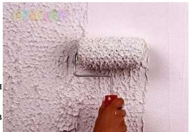
Оздоблювальний матеріал рекомендується наносити на стіни, обкатавши попередньо інструмент в контейнері з фарбою. Якщо в процесі роботи стали утворюватися надлишки, їх необхідно прибрати за допомогою шпателя.
