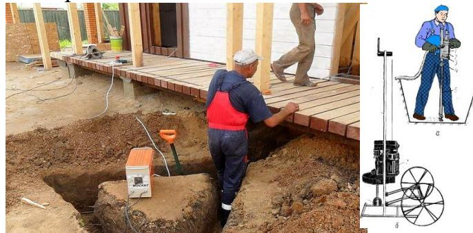
Занурення стержня в ґрунт методом вкручування: а - електросвердлом; б - заглиблювачем ЗЕ-1;
