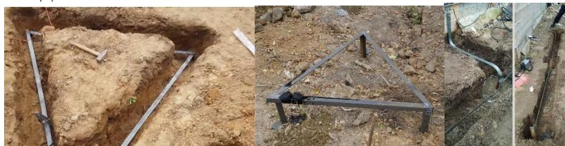
Електроди заземлювача розташовують так, щоб їх верхні кінці були нижче від рівня землі на 0,5-0,7 м. Це дає змогу знизити опір розтіканню заземлювачів, а також зменшити коливання опору заземлювачів,
