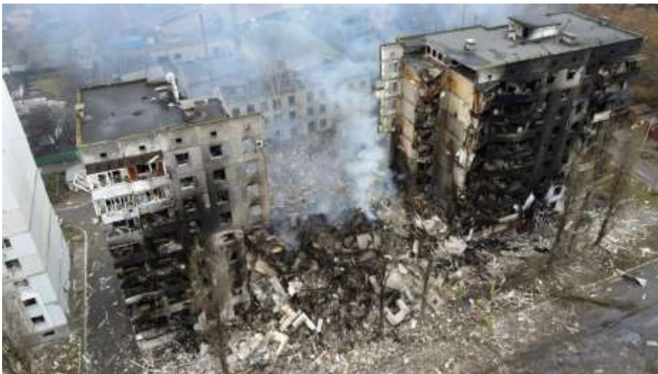
Іл. 11. Руйнування будівлі внаслідок обстрілу
