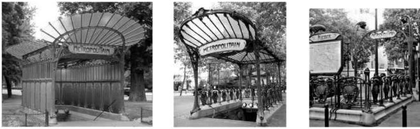
Рис. 70. Оформлення входів на станції паризького метро (1898 – 1905 рр.), арх. Е. Гімар
