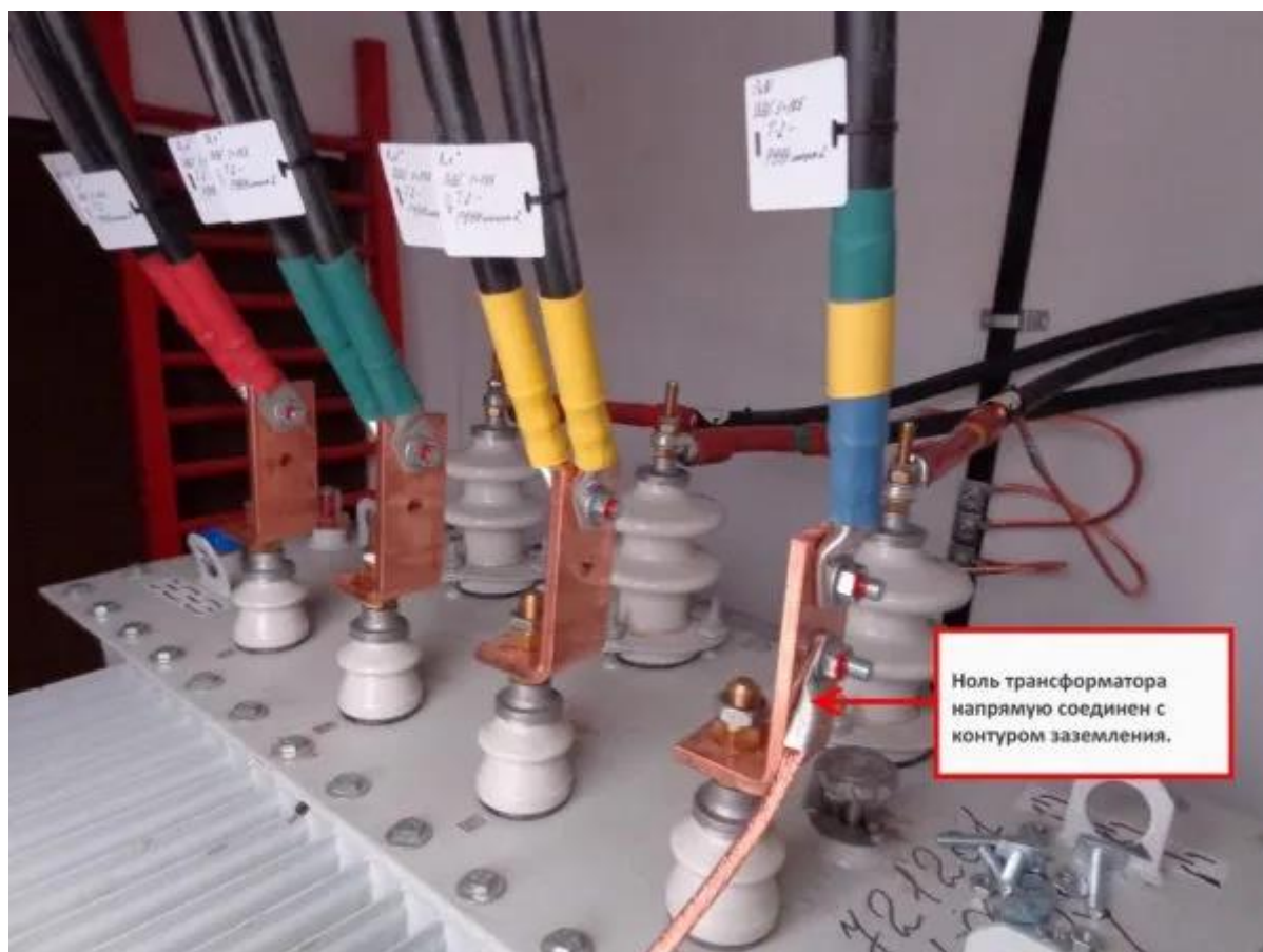
Рис. 2 Захисне занулення
